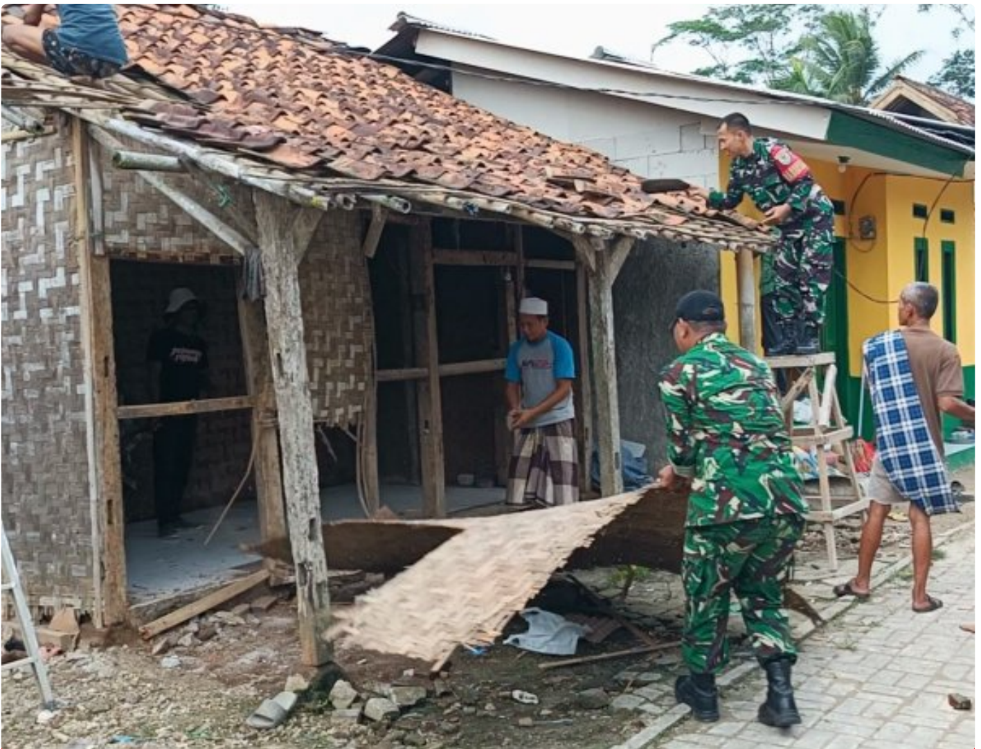
Pembongkaran Rumah Bapak Narmin
